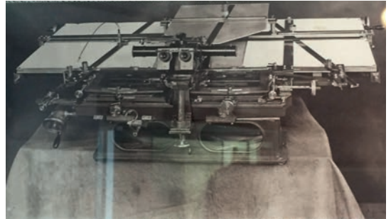
Abb. 6: Der Stereoaograph nach E. v. Orel
