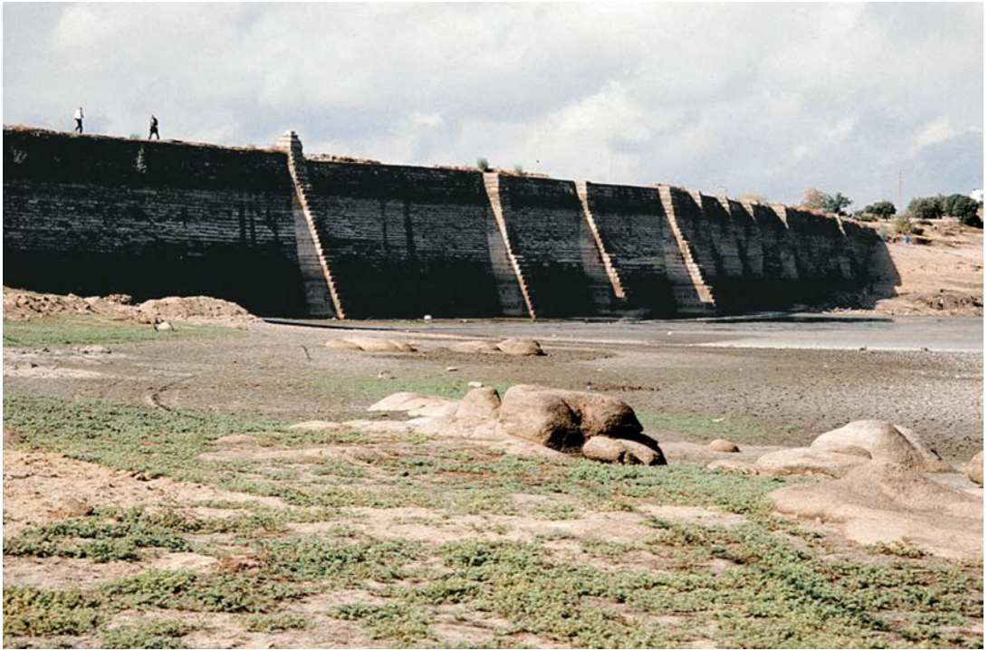
Abb. 7: Mérida (Spanien), Proserpina-Talsperre.
