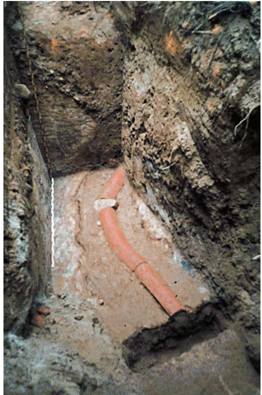
Abb. 14: Düren, Wasserleitung im Aquäduktunnel durch den Drover Berg.
