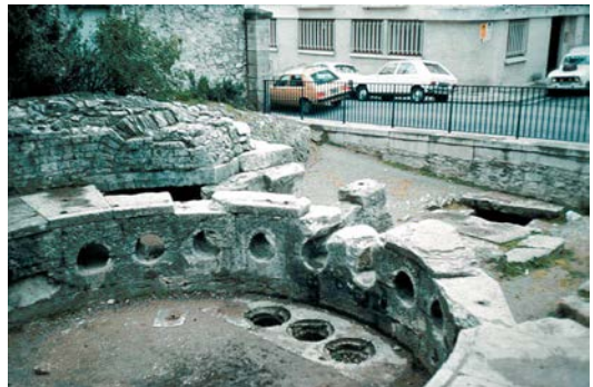
Abb. 22: Nîmes (Frankreich), Wasserverteiler.
