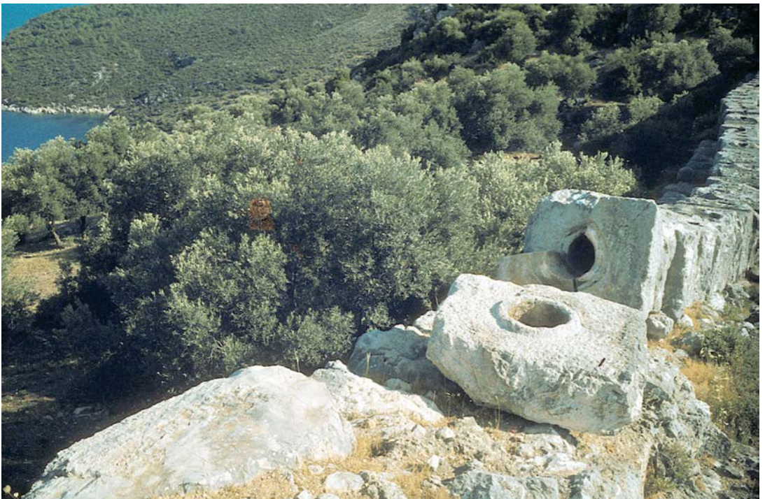
Abb. 17: Patara (Türkei), Steinrohre einer Druckleitung.
